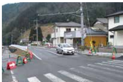
【内宮地頭線道路高上げ工事】
