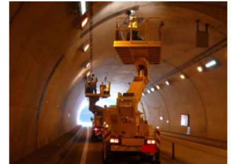
トンネル内 道路附属物点検
