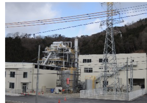
バイオマス発電所
