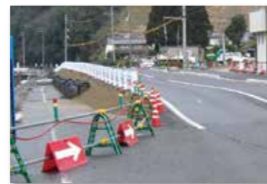
(内宮地頭線道路嵩上げ工事)
