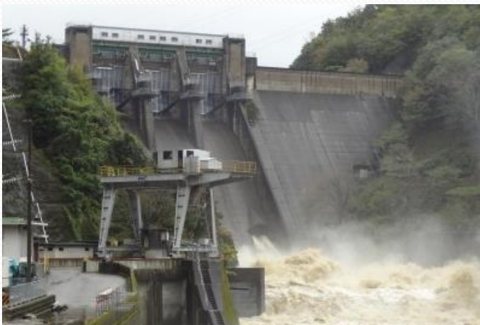
大野ダムの放流状況
