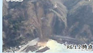
写真④ 国道249号法面崩落
