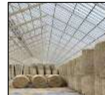
簡易倉庫の設置
