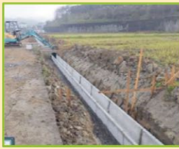
用水路の改修
