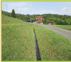
防草シートの設置 (写真はカバープランツ)
