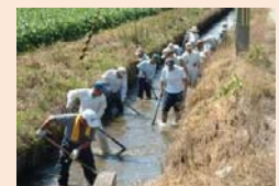
水路の泥上げ
