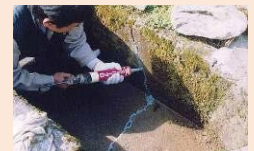
水路のひび割れ補修
