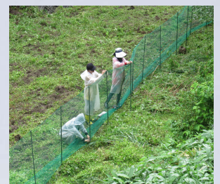
獣害防止ネット設置作業
