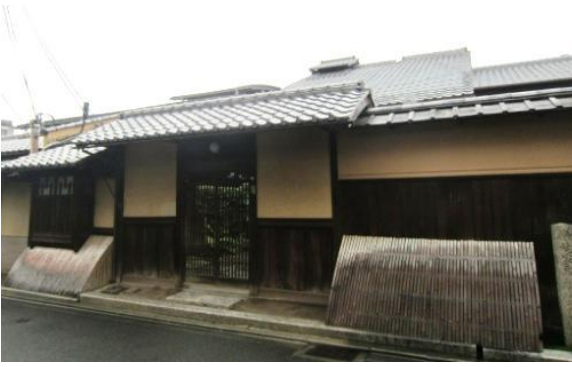
樂家住宅（左京区） 国登録文化財・門等の屋根（瓦葺）修理
