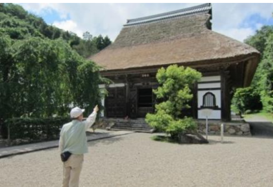
安国寺・本堂（綾部市） 府登録文化財・本堂、庫裏 屋根(茅葺)等修理
