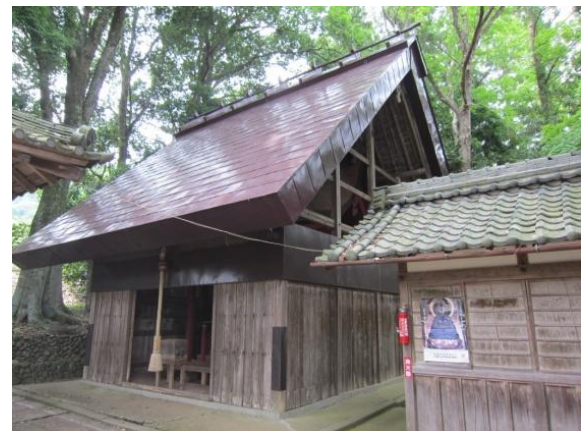
荒井神社・本殿（南丹市） 府指定文化財・本殿 アライグマ対策設備設置
