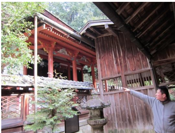
高神社・本殿（井手町） 府指定文化財・本殿 自動消火設備改修
