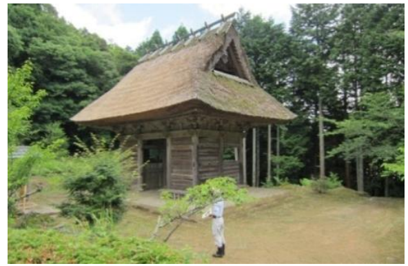
岩王寺・仁王門（綾部市） 府登録文化財・仁王門 屋根(茅葺)修理
