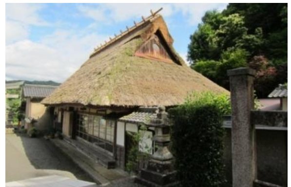
荒木家住宅・主屋（舞鶴市） 府指定文化財・主屋 屋根(茅葺)修理
