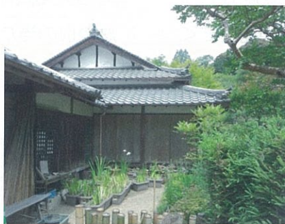
写真1 浄瑠璃寺大日堂（木津川市） 部分修理（アライグマ対策含）
