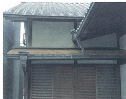
写真2 国登録文化財・楽々荘(亀岡市) 玄関庇(こけら葺)の葺替修理
