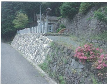
写真6 古岩神社（京丹後町） 防災道路（参道）修理
