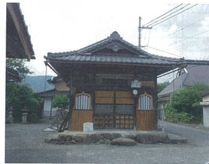
写真7 長尾薬師堂（福知山市） 屋根葺替修理
