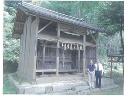
写真5 若宮神社本殿（舞鶴市） 屋根・木部修理
