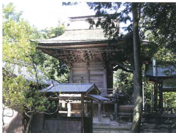
写真8 神谷神社・本殿（京丹後市） 府指定文化財・本殿 屋根等修理
