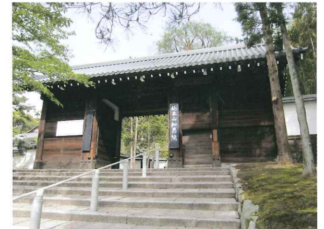
写真2 知恩院・黒門（東山区） 府指定文化財・黒門 半解体修理
