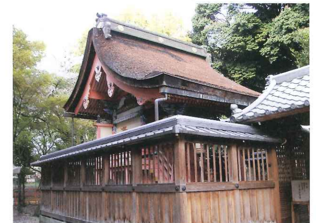
写真4 旦椋神社・本殿（宇治市） 府登録文化財・本殿 屋根檜皮葺修理
