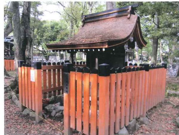
写真1 賀茂別雷神社・末社梶田社（北区） 末社梶田社 屋根檜皮葺修理
