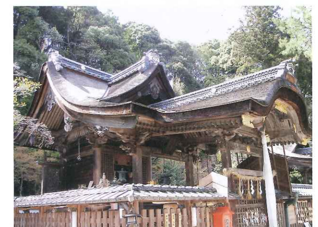
写真6 鍬山神社・本殿（亀岡市） 府登録文化財・本殿等 軒裏修理（アライグマ被害修理）
