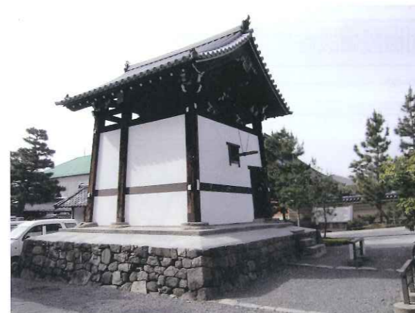
写真3 建仁寺・大鐘楼（東山区） 府指定文化財・大鐘楼 解体修理
