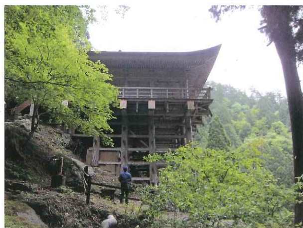
写真9 峰定寺・本堂（左京区） 重要文化財・本堂 消防設備復旧
