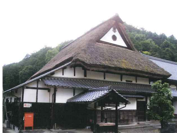
写真7 安国寺・庫裏（綾部市） 府登録文化財・庫裏 屋根等修理
