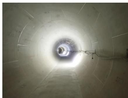
南幹線管渠シールド工事完成
