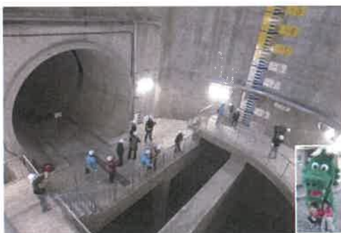
乙訓ポンプ場
