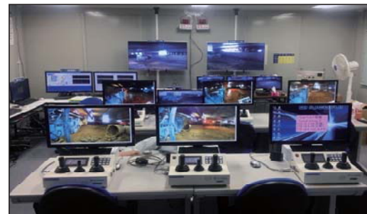
地上遠隔操作室・計測室
