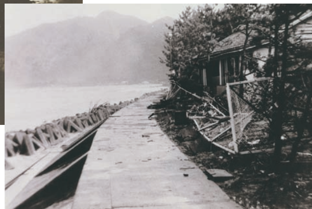
越波により被災した人家
