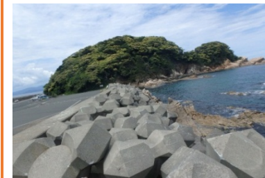
2 竜宮浜漁港海岸(小橋地区)
