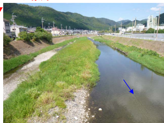
2014 年 9 月 22 日（施工後約 3 年 4 ヶ月） （H26 台風 11 号後 約 1 ヶ月）
