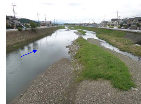
2015 年 9 月 25 日（施工後約 4 年 4 ヶ月）
