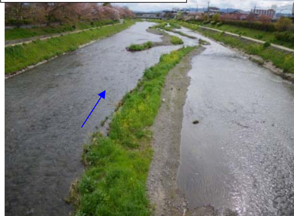
2010 年 4 月 16 日（施工直後）
