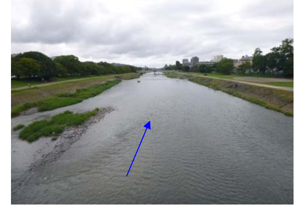
2015 年 9 月 25 日（施工後約 4 年 6 ヶ月） （H27 台風 11 号後 約 2 ヶ月）
