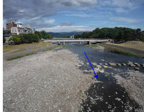
2013 年 10 月 11 日 (施工後 約 3 年 7 ヶ月・18 号出水後)
