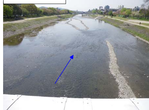
2011 年 4 月（施工直後）
