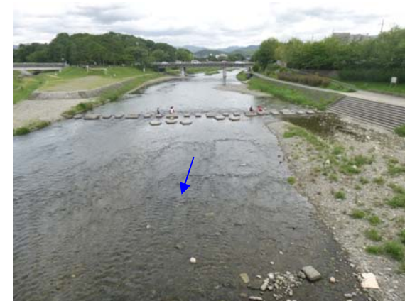
2015 年 7 月 13 日 (施工後約 1 年 4 ヶ月)
