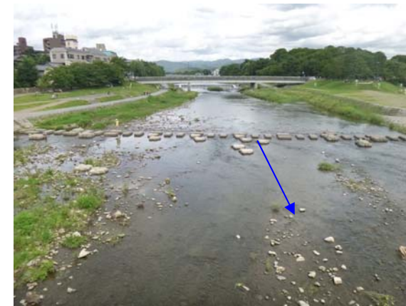
2015 年 7 月 13 日 (施工後約 1 年 4 ヶ月)
