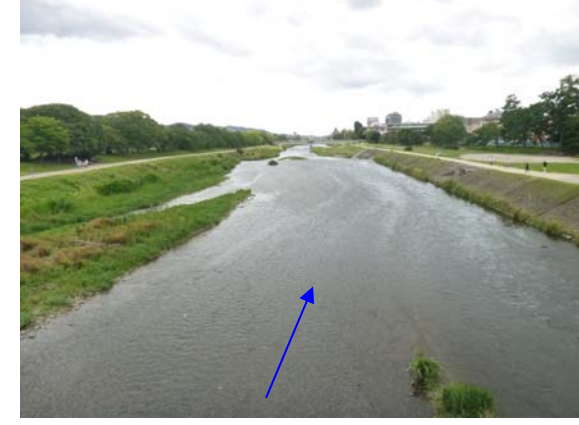
2015 年 7 月 13 日（施工後約 4 年 4 ヶ月） （H26 台風 11 号後 約 11 ヶ月）
