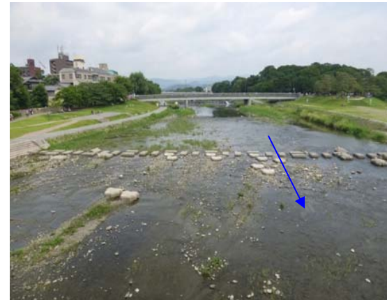
2014 年 7 月 17 日 (施工後約 4 ヶ月)
