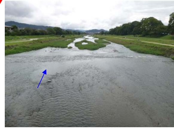
2015 年 9 月 25 日（施工後約 3 年 6 ヶ月）
