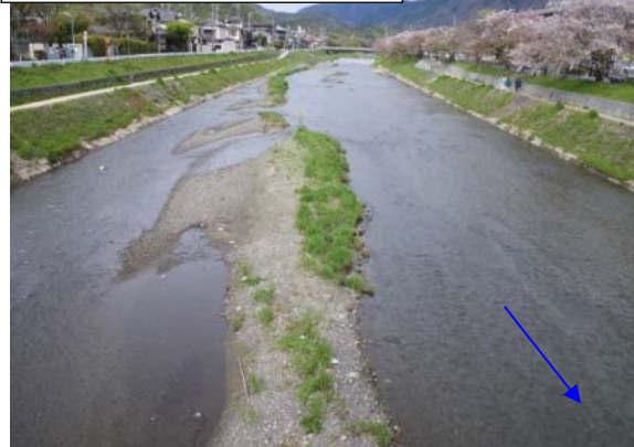
2010 年 4 月 16 日（施工直後）
