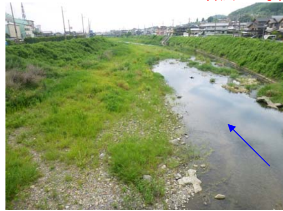
2014 年 7 月 17 日（施工後約 3 年 4 ヶ月） （H25 台風 18 号後 約 10 ヶ月）
