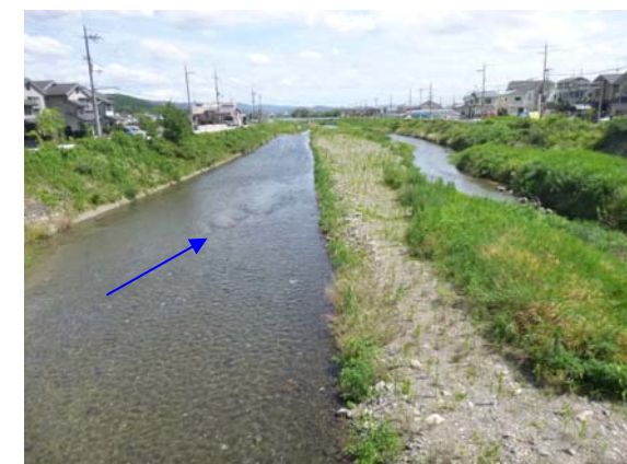
2015 年 7 月 13 日（施工後約 4 年 2 ヶ月）
