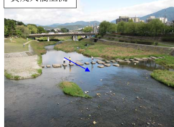
2009 年 10 月 1 日 (施工前)
