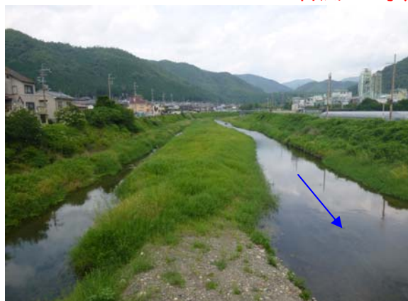
2014 年 7 月 17 日（施工後約 3 年 2 ヶ月） （H25 台風 18 号後 約 10 ヶ月）
