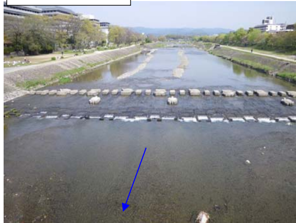
2011 年 4 月（施工直後）
