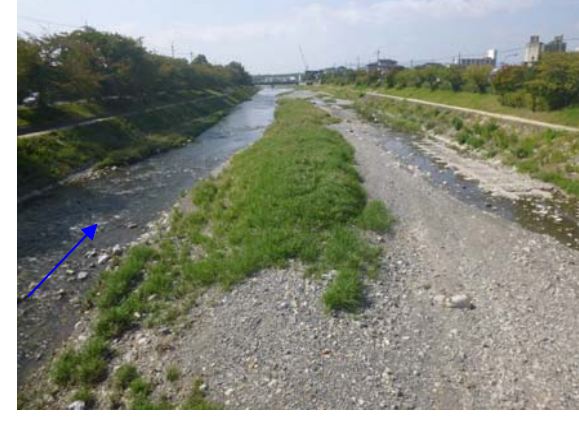
2014 年 9 月 22 日（施工後約 4 年 6 ヶ月） （H26 台風 11 号後 約 1 ヶ月）
