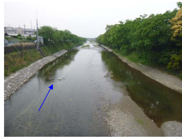
2012 年 5 月 8 日 (施工後 約 2 ヶ月)
