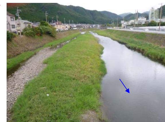
2015 年 9 月 25 日（施工後約 4 年 4 ヶ月）
