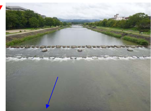
2015 年 9 月 25 日（施工後約 4 年 6 ヶ月） （H27 台風 11 号後 約 2 ヶ月）
