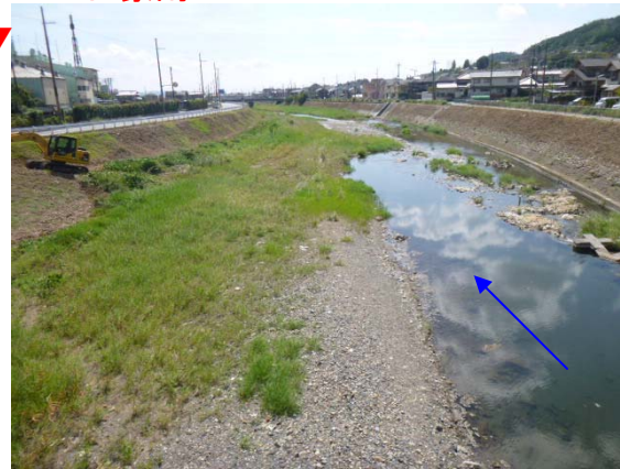
2014 年 9 月 22 日（施工後約 3 年 6 ヶ月） （H26 台風 11 号後 約 1 ヶ月）
