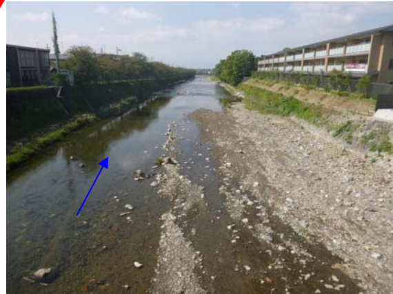
2014 年 9 月 22 日（施工後約 2 年 6 ヶ月） (H26 台風 11 号後 約 1 ヶ月)
