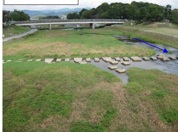
2009 年 10 月 1 日 (施工前)
