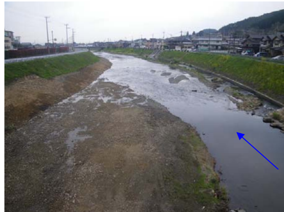
2011 年 4 月（施工直後）
