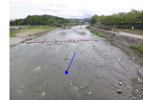
2015 年 9 月 25 日 (施工後約 1 年 6 ヶ月)
