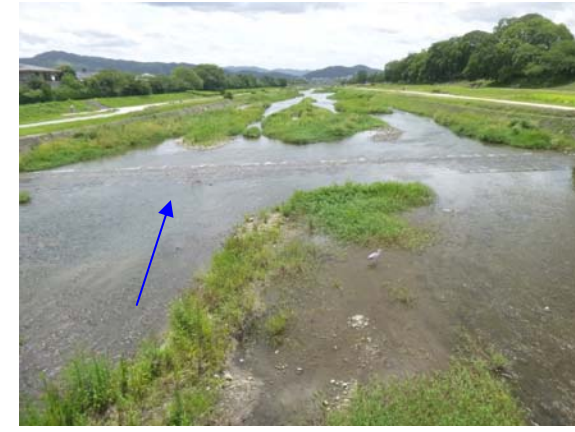
2015 年 7 月 13 日（施工後約 3 年 4 ヶ月）
