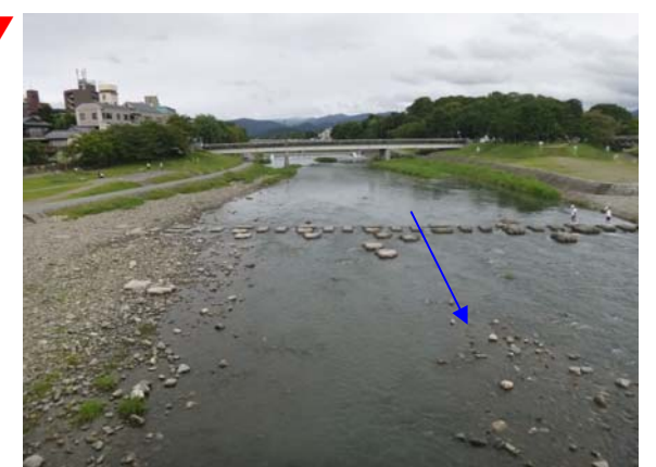
2015 年 9 月 25 日 (施工後約 1 年 6 ヶ月)
