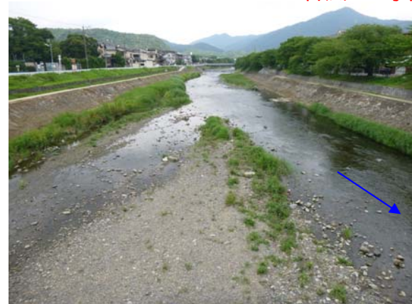
2014 年 7 月 17 日（施工後約 4 年 4 ヶ月） （H25 台風 18 号後 約 10 ヶ月）
