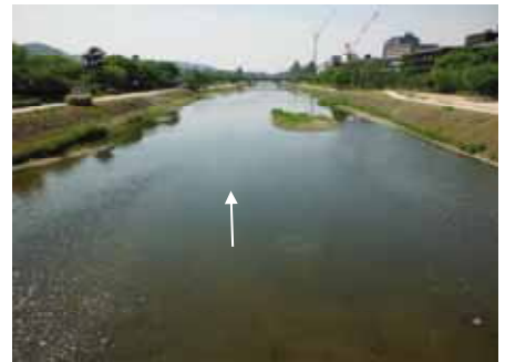
河床整正前後の状況（丸太町橋下流）
