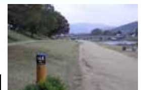
高水敷に設置した距離標
