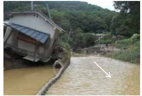
志津川の被災状況
