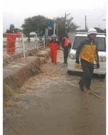
鴨川から堤内への越水状況(平成 25 年台風 18 号)
