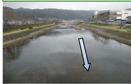
施工後 5 ヶ月 (H25. 8)
