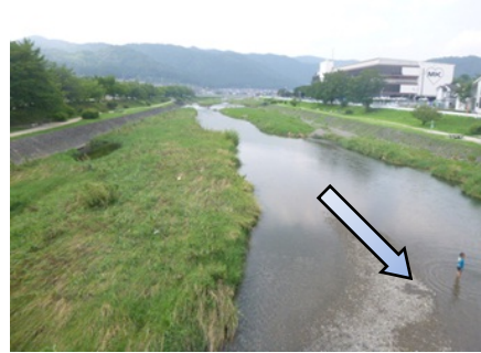
施工直後 (H25. 3)
