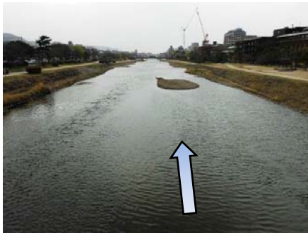
施工後 5 ヶ月 (H25. 8)
