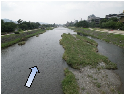
施工直後 (H25. 3)
