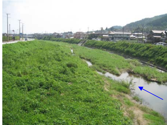
2010 年 8 月 19 日（施工前）
