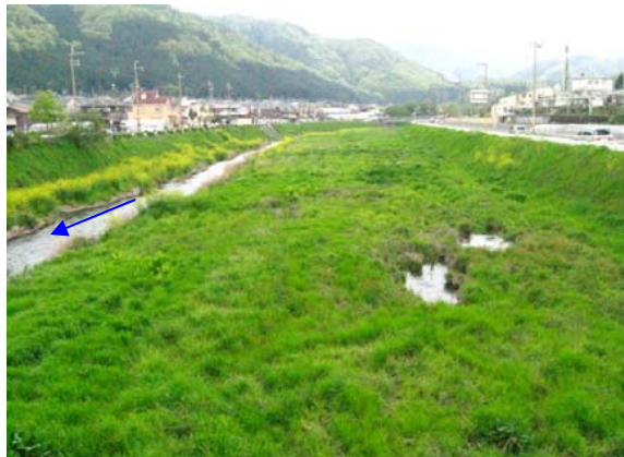
2010年4月30日（施工前）
