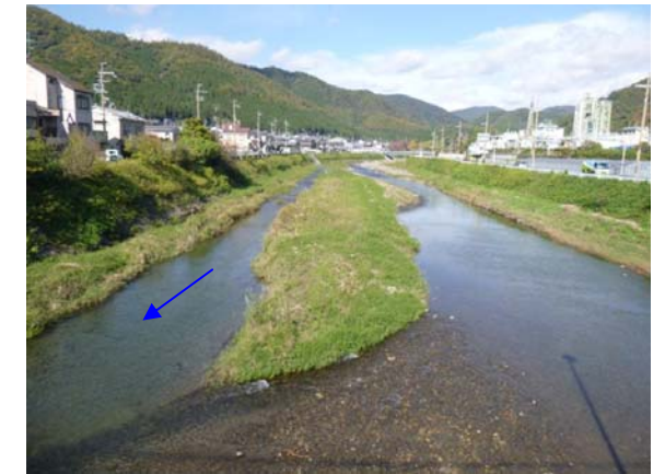
2013年11月14日 （施工後 約2年8ヵ月・出水後）
