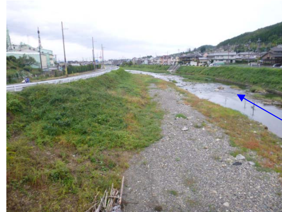
2012 年 10 月 18 日 （施工後 約 1 年 7 ヶ月）
