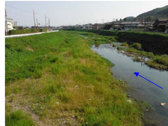
2013 年 8 月 14 日 （施工後 約 2 年 5 ヶ月・出水前）
