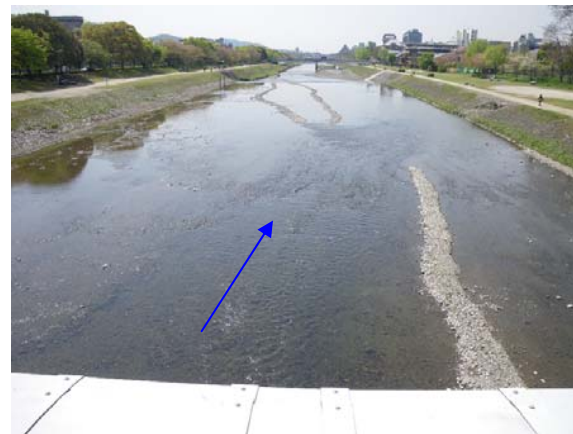
2011 年 4 月（施工直後）
