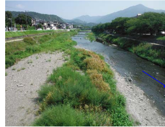
2013 年 8 月 14 日 （施工後 約 3 年 5 ヶ月・出水前）
