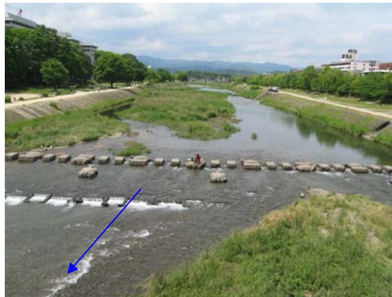
2010 年 5 月 31 日（施工前）
