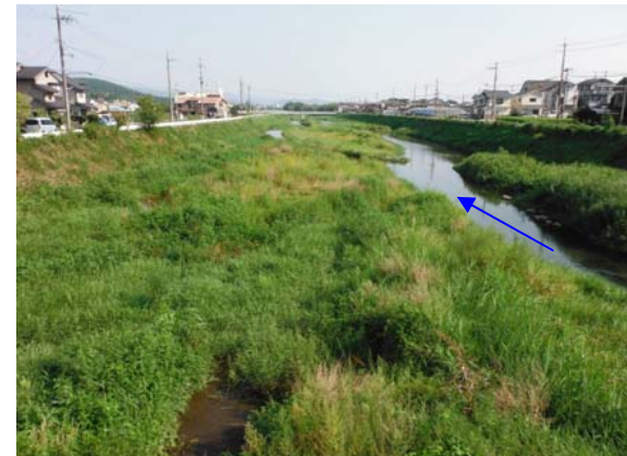
2013年8月14日 （施工後 約2年5ヵ月・出水前）
