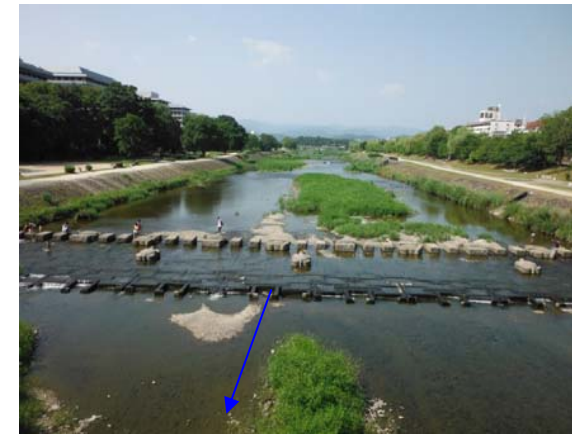
2013 年 8 月 14 日 （施工後 約 2 年 5 ヶ月・出水前）
