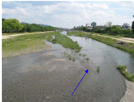
2010 年 5 月 31 日（施工前）
