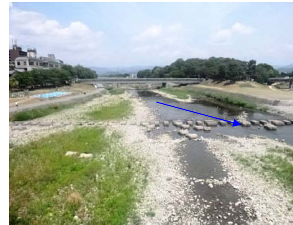
2013 年 6 月 17 日 (施工後 約 3 年 3 ヶ月)
