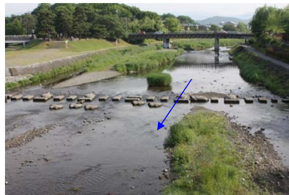
2012 年 5 月 16 日 (施工後 約 2 年 2 ヶ月)
