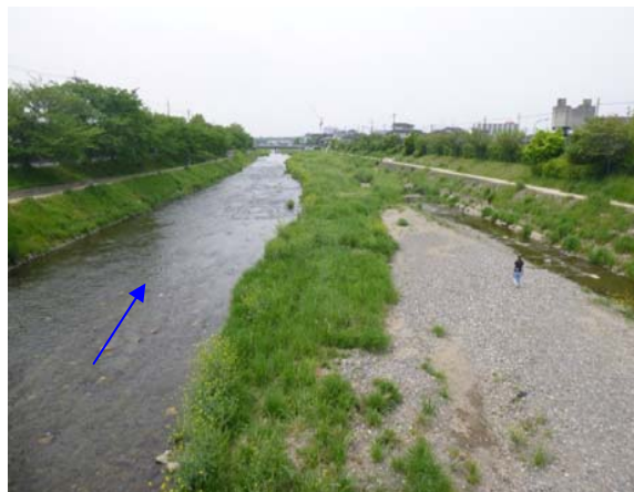
2012 年 5 月 8 日（施工後 約 2 年 2 ヶ月）
