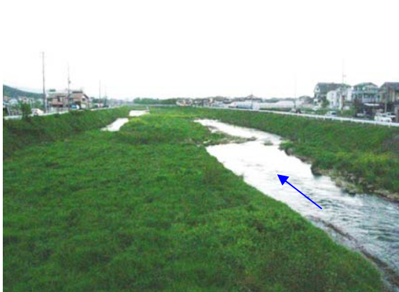
2010年4月30日（施工前）
