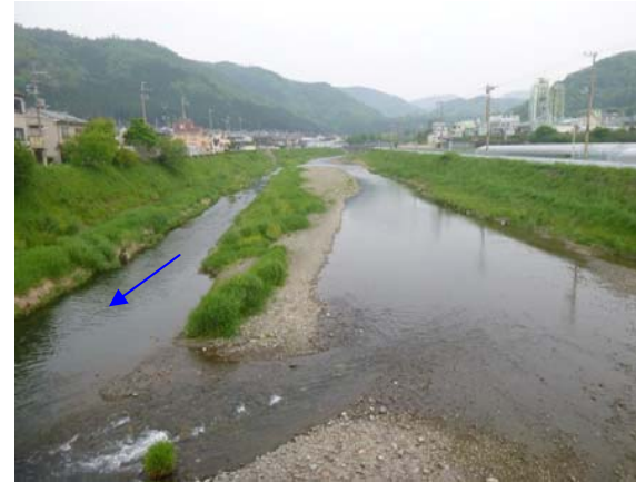
2012年5月8日（施工後 約1年2ヵ月）
