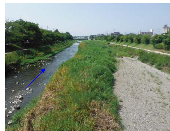
2013 年 8 月 14 日 （施工後 約 3 年 5 ヶ月・出水前）
