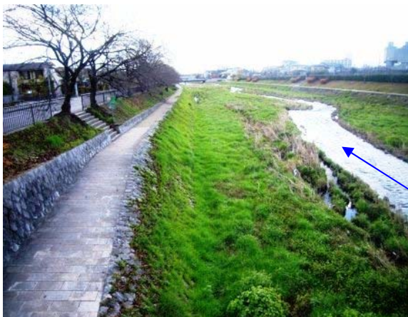
2009 年 12 月 16 日（施工前）
