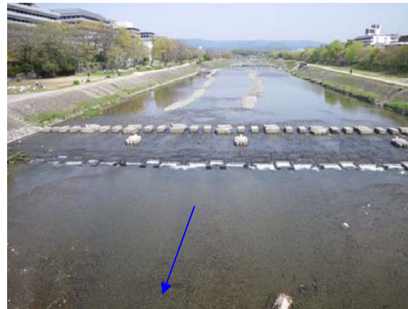
2011 年 4 月（施工直後）
