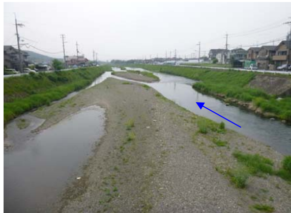
2012年5月8日（施工後 約1年2ヵ月）
