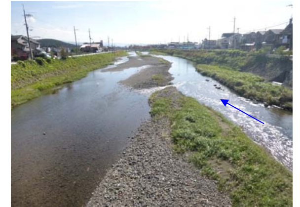
2013年11月14日 （施工後 約2年8ヵ月・出水後）
