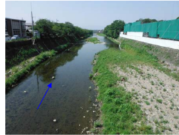
2013 年 8 月 14 日 （施工後 約 1 年 5 ヶ月・出水前）
