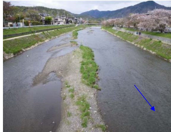
2010 年 4 月 16 日（施工直後）
