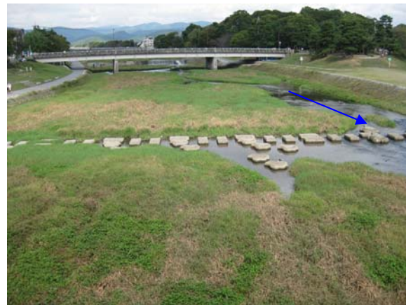
2009 年 10 月 1 日 (施工前)
