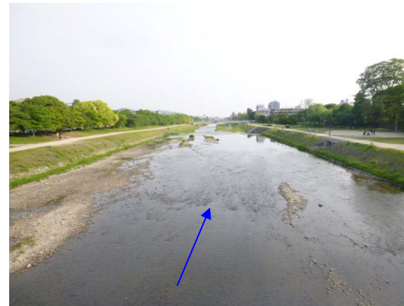
2012 年 5 月 14 日（施工後 約 1 年 2 ヶ月）
