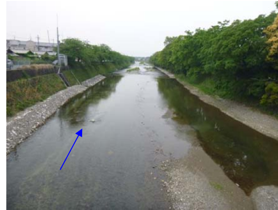
2012 年 5 月 8 日 （施工後 約 2 ヶ月）
