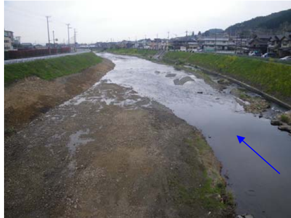
2011 年 4 月（施工直後）
