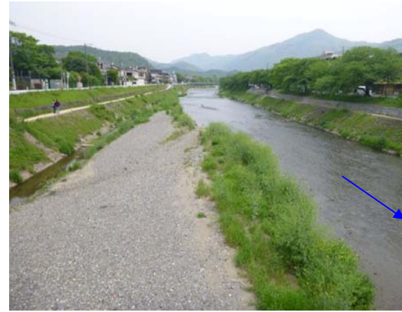
2012 年 5 月 8 日（施工後 約 2 年 2 ヶ月）
