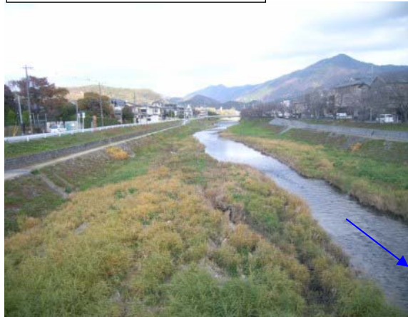
2009 年 12 月 16 日（施工前）
