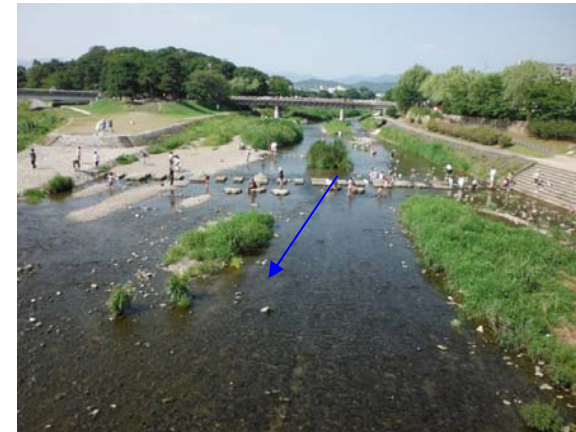
2013 年 8 月 14 日 (施工後 約 3 年 5 ヶ月・出水前)
