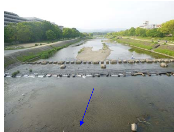
2012 年 5 月 14 日（施工後約 1 年 2 ヶ月）
