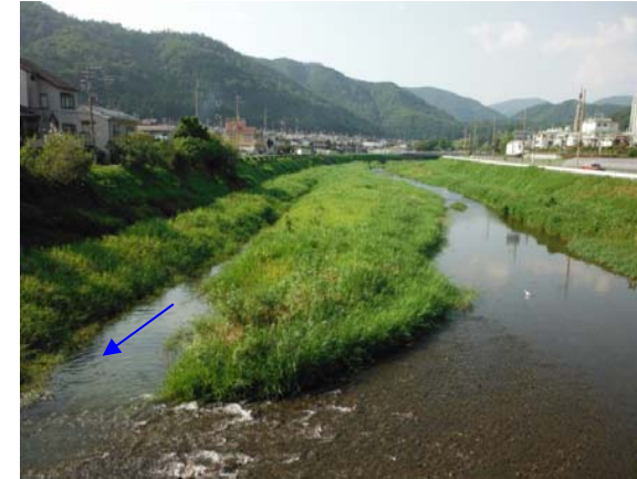
2013年8月14日 （施工後 約2年5ヵ月・出水前）
