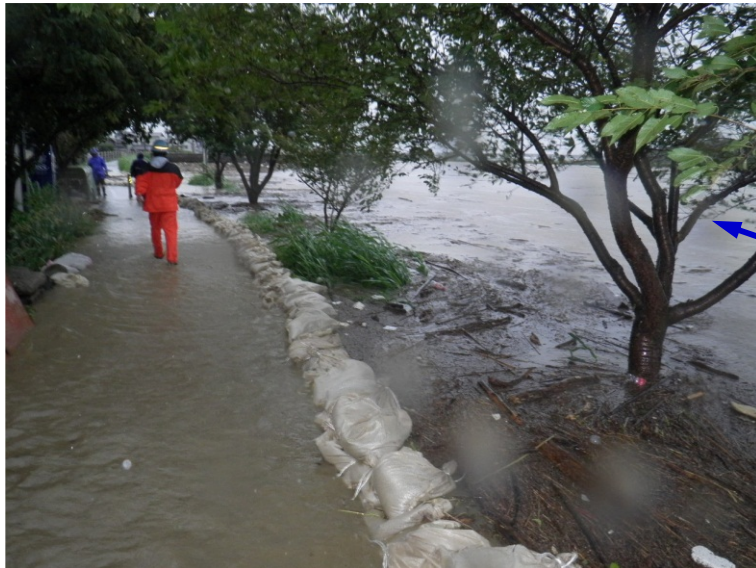
堤防からの溢水
