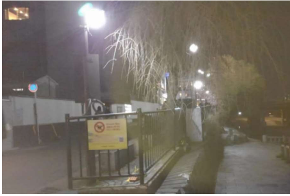
LED 照明装置の設置（令和4年3月）
