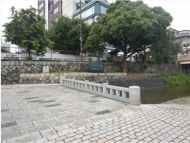
スロープ下花壇の石積の高さを上げた整備を実施（令和5年6月）
