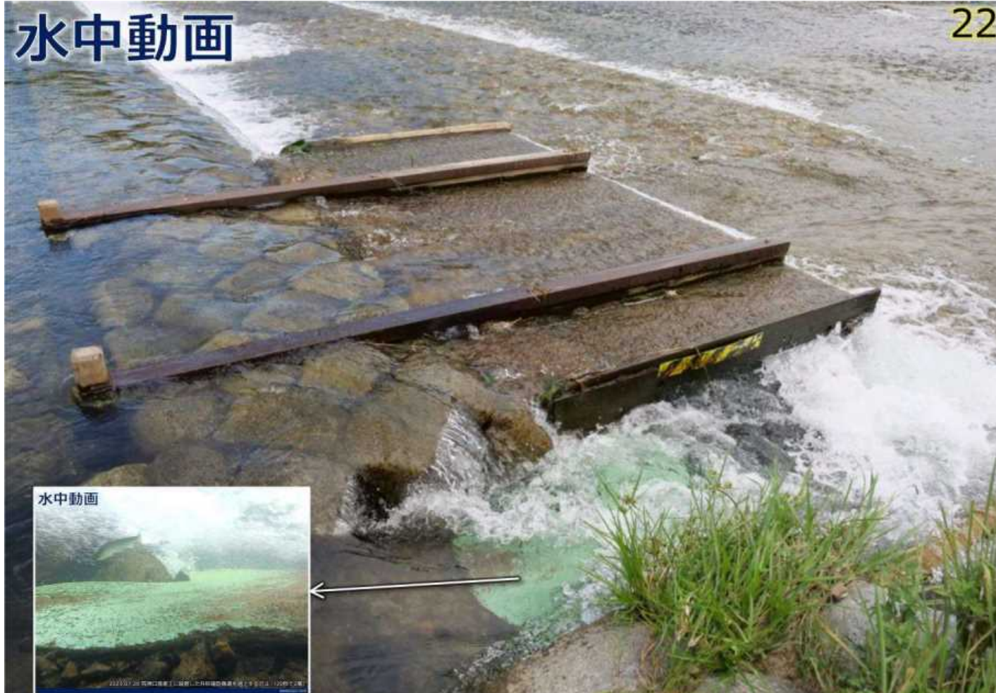
2021.07.20 荒神口落差工に設置した井桁箱型魚道を遡上するアユ (20秒で2尾)
