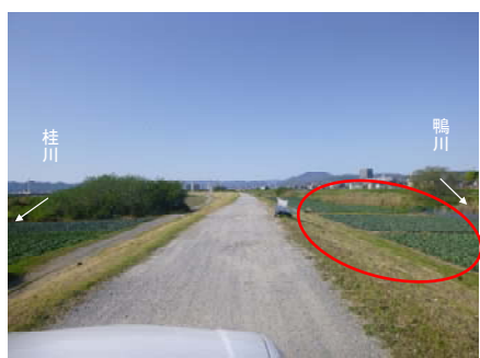
河川区域内行為（桂川合流点付近）
