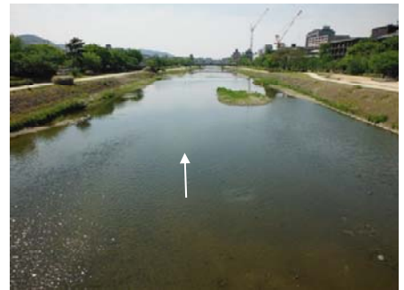
河床整正前後の状況 (丸太町橋下流)
