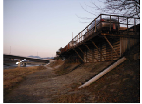
勸進橋上流左岸
