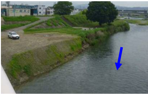
整備前（鳥羽大橋上流右岸）
