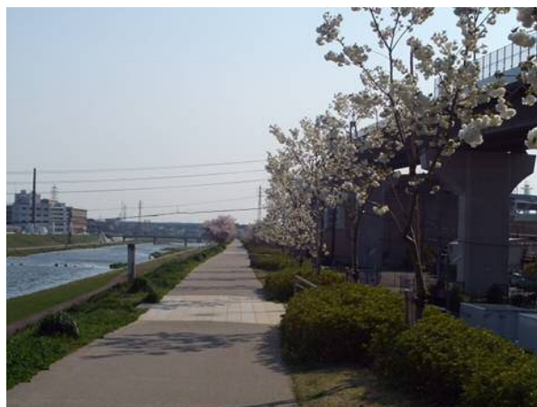
図- 12 勸進橋から水鷄橋区間の整備状況
