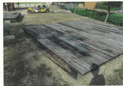
（整備前 テントデッキ）
