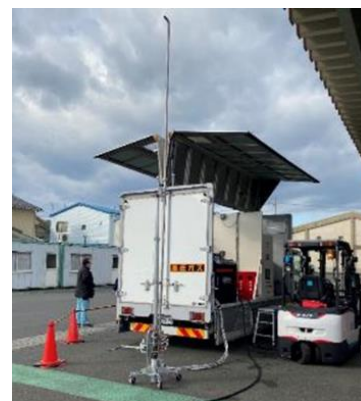
燃料電池フォークリフト導入実証事業の様子
