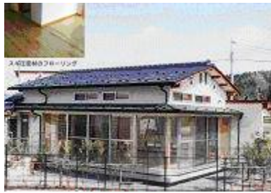
府営住宅への府内産材利用
