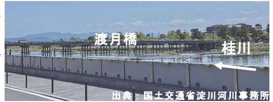
出典：国土交通省淀川河川事務所 桂川嵐山地区左岸溢水対策（可動式止水壁）
