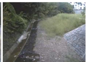
環境に配慮した護岸
