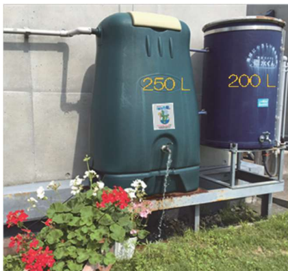
設置例 1 (府庁2号館屋上)
