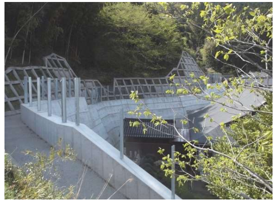
志高（舞鶴市）擁壁工
