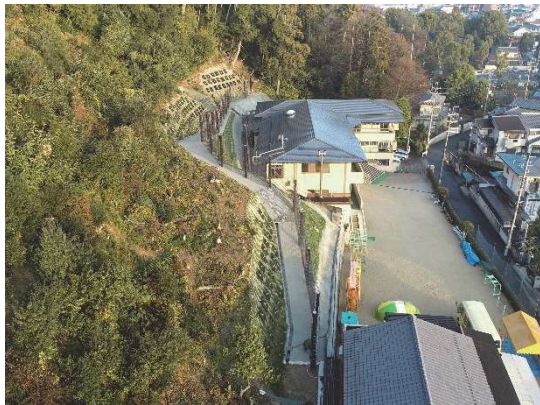
松室（京都市西京区）土砂防護柵
