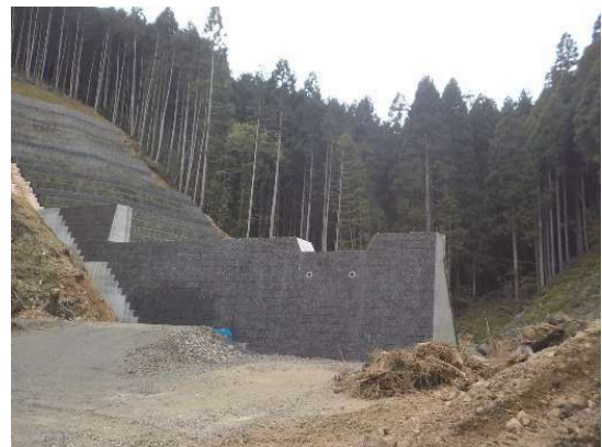
蛙ヶ谷川（京都市北区）砂防えん堤
