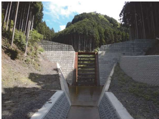
中ノ谷川（宇治田原町）砂防えん堤
