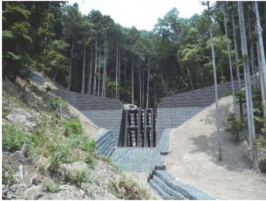
北川（京都市西京区）支川えん堤
