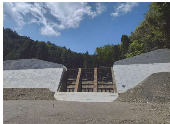
篠原西一谷川（京丹波町）砂防えん堤
