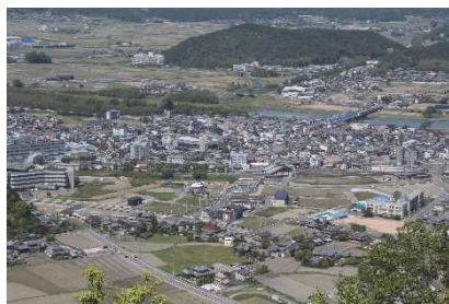
八木駅西地区土地区画整理事業（施行中） （南丹市〔組合施行〕）
