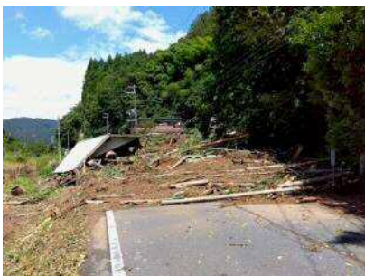
(主) 綾部大江宮津線 (福知山市大江町南有路) 土砂流出 延長30m
