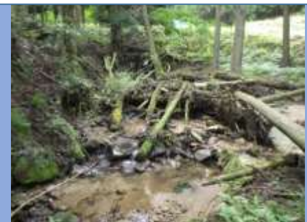
危険木の撤去(実施前)
