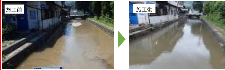
図-3 神子川維持掘削 (丹後広域振興局)
