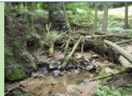
危険木の撤去（実施前）
