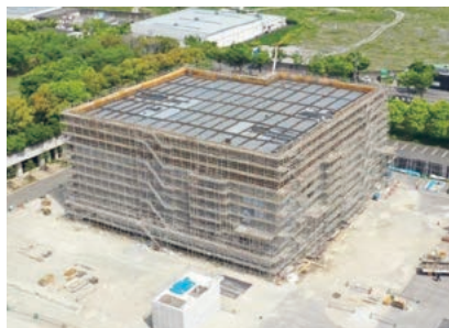
桂川に排水するための呑龍ポンプ場(整備中)
