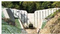
長岡京市粟生の坂川砂防えん堤(令和3年3月完成)
