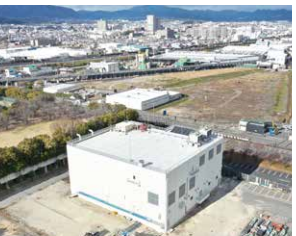
供用された呑龍トンネル北幹線の18号被 害により、平成25年台風第18号の浸水 が解消。今年度、南幹線と併用し、安 全がさらに高まります
