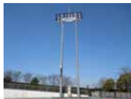
夜間照明の設置により夜間利用が可能に
