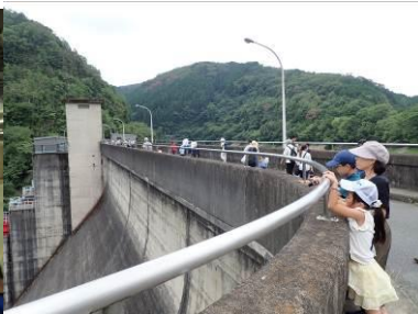
室生ダムの見学
