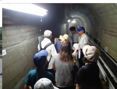
ダム内部（布目ダム）
