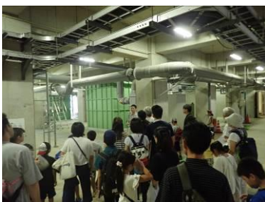
宇陀川浄化センターの見学
