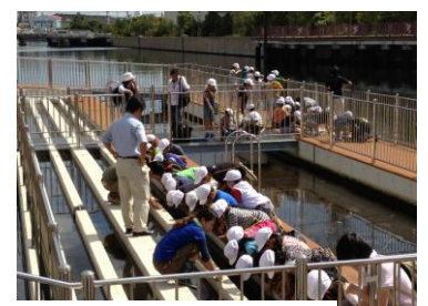
水質浄化施設
