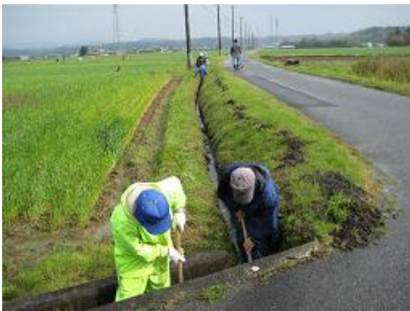
溝掘り共同作業
