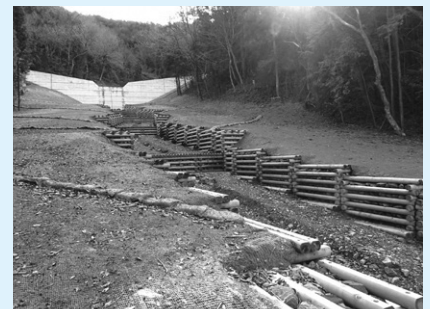
福知山市大堀地区に設置した治山ダム
