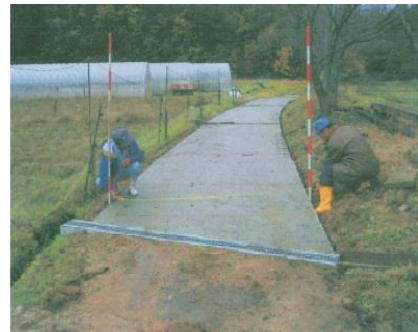
コンクリート舗装
