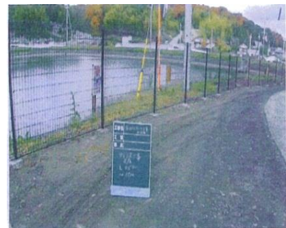
フェンス設置後
