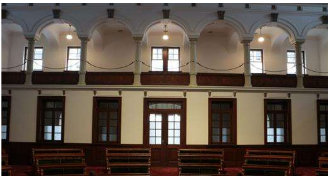
旧議場北面 建具の修理が完了し復旧した。
