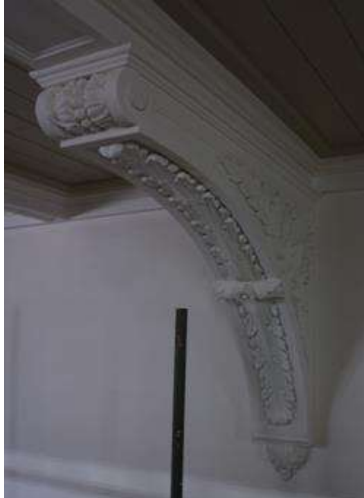
修理が完了した漆喰彫刻
