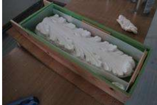
残っている彫刻を元に石膏で模る工程
