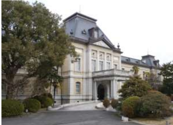
京都府庁旧本館 正面全景 正面中央に特に意匠が凝らされています。
