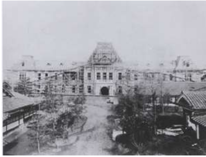
大部分の外観工事が完了した旧本館*
