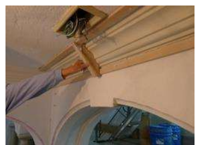
上下に正規を取り付け、蛇腹を施工中
