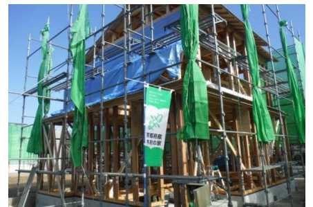
施工中の全景 普及啓発(のぼりの掲示)
