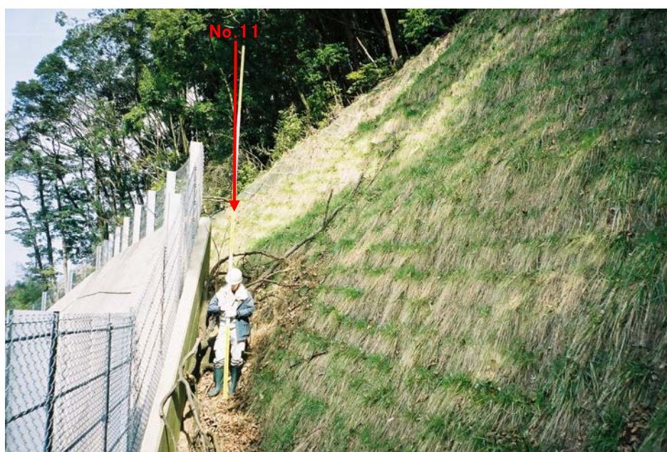
写真 2.5 待受対策施設ポケット状況
