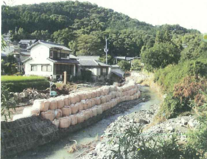
大型土のう設置状況(20日17時)
