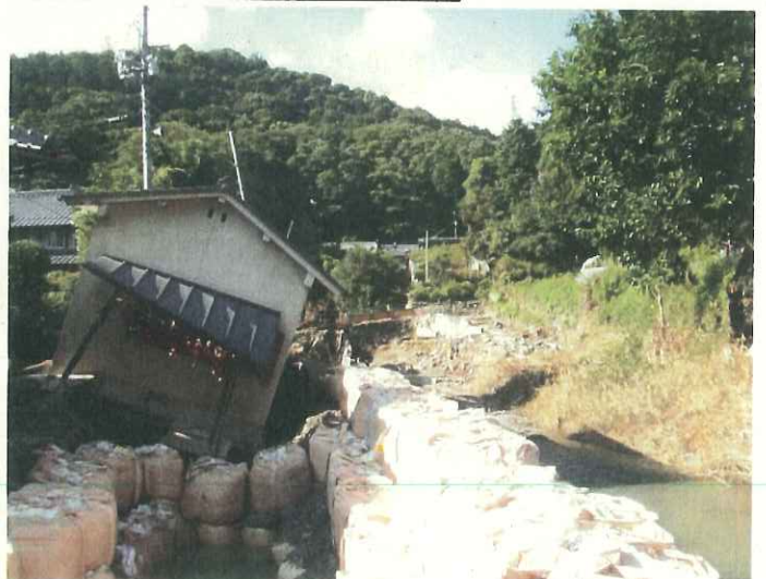
大型土のう設置状況(20日17時)
