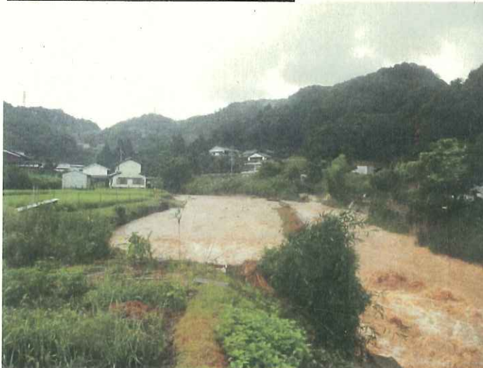
14日未明 決壊箇所(左岸)
