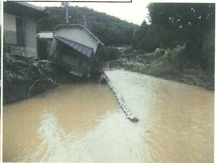
14日未明 決壊箇所 民家
