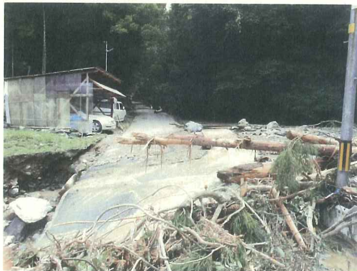
14日未明 土砂閉塞箇所
