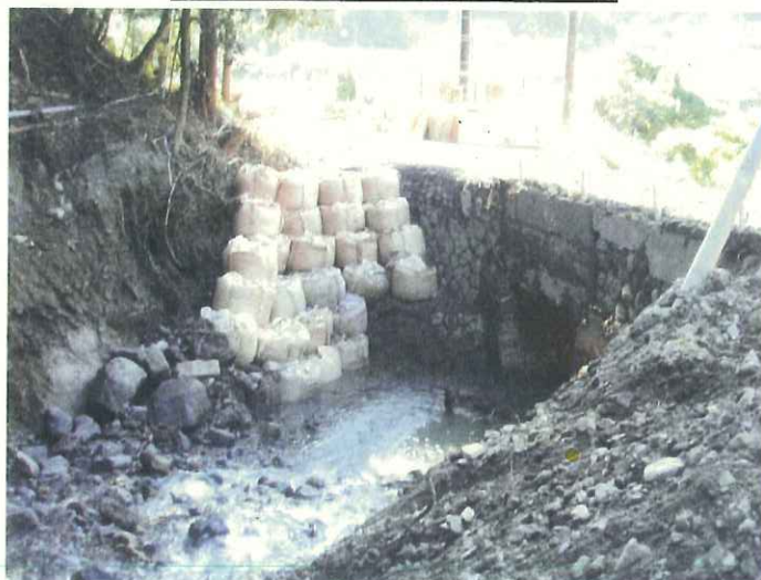
土砂撤去状況(20日17時)
