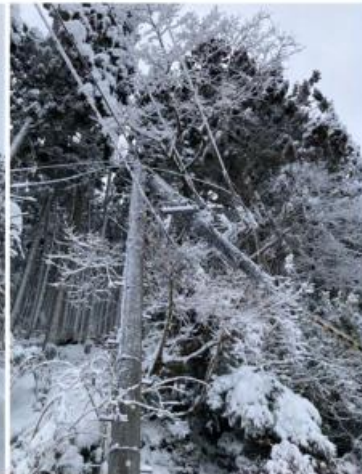
船井郡京丹波町上粟野付近
