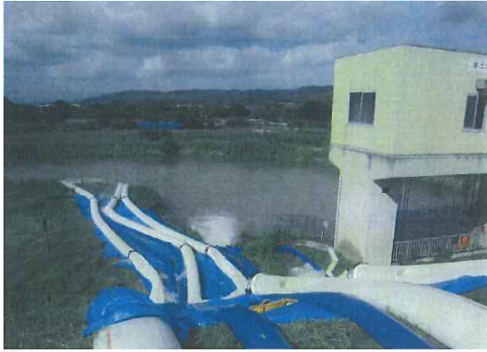
小川合同樋門(木津川市)
